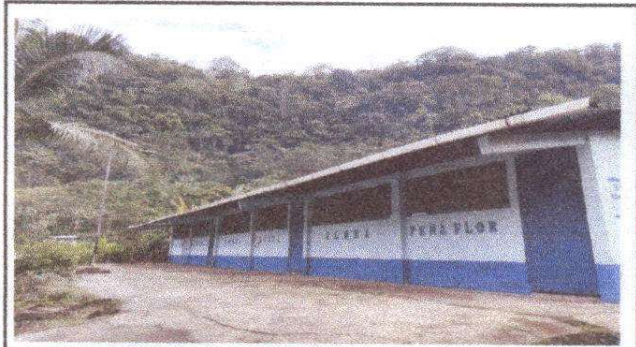
Foto 3 Cambio de canal de agua por deterioro del existente
